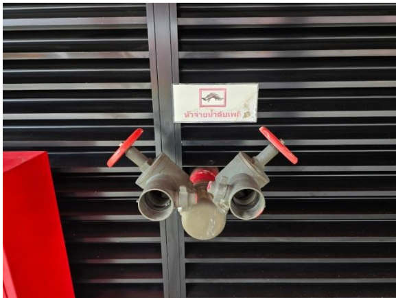
รูปที่ 2-27 หัวจ่ายน้ำดับเพลิงชั้นตาดฟ้า
