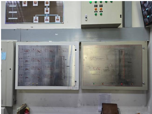
รูปที่ 2-35 ตู้ควบคุมระบบป้องกันอัคคีภัย และเบรโทรฉุกเฉิน
