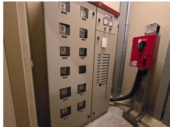
รูปที่ 2-58 มิเตอร์ไฟแต่ละชั้น
